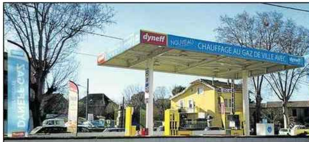
La station de Béziers avenue du Pont vieux
